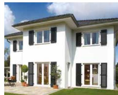
**Nachher:** Aus dem Haus ist nahezu eine mediterrane Villa geworden. Im Erdgeschoss wurden die kleinen Fenster komplett durch bodentiefe hochwärmedämmende Fenstertüren mit einer GAYKOSafeGA® Sicherheitsausstattung ersetzt. Ein neuer Anstrich und die Ergänzung aller Fenster mit harmonischen Klappläden, verleihen dem Haus zusätzliches Flair.
